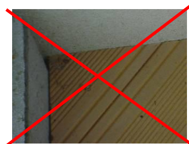
Dodržujte mezeru 5 mm mezi prkny na šířku a 15 mm mezeru mezi konci prken a zdi
