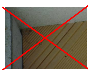
Dodržujte mezeru 5 mm mezi prkny na šířku a 15 mm mezeru mezi konci prken a zdi
