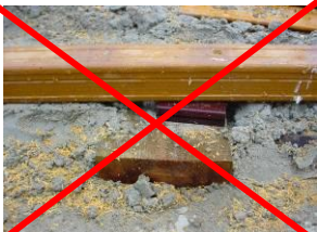
Nezapouštějte nosiče do betonu
